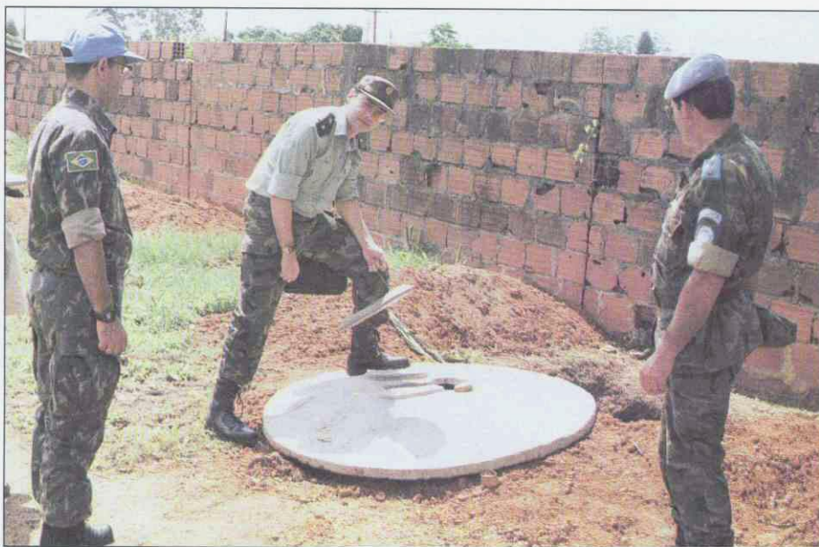
Fig. 5.-Letrina tipo pozo con cubierta de cemento en el Area de desmovilización de Chimoio. Obsérvese la tapadera que evitará las visitas de artrópodos y lo angosto del orificio de evacuación. En la foto, el Comandante Alsina y otros oficiales de ONUMOZ examinando la letrina.
