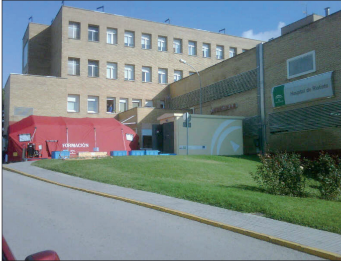
Figura 1. Estación de Descontaminación NBQ Hospitalaria.
