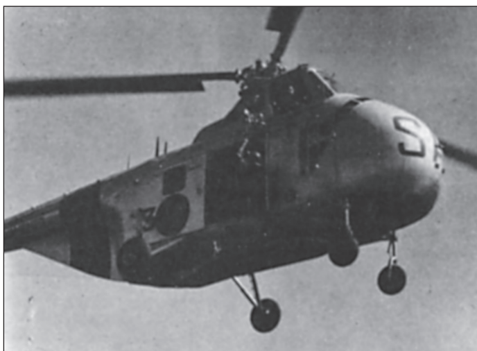
Figura 8. El primer helicóptero de salvamento en España, Sikorsky H-19 presentaba una innovación característica, el motor se encontraba en la parte delantera del fuselaje, quedando un gran espacio despejado para la disposición de camillas o zona de atención de los enfermos, disponía de un gran portón y una grúa para izar rescata-dos. Imagen Revista Aeronáutica y Astronáutica Española.
