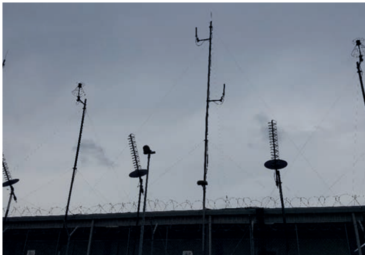
Algunas de las antenas empleadas por los data link vía satélite (INMARSAT, UHF SATCOM y Ku SATCOM)
