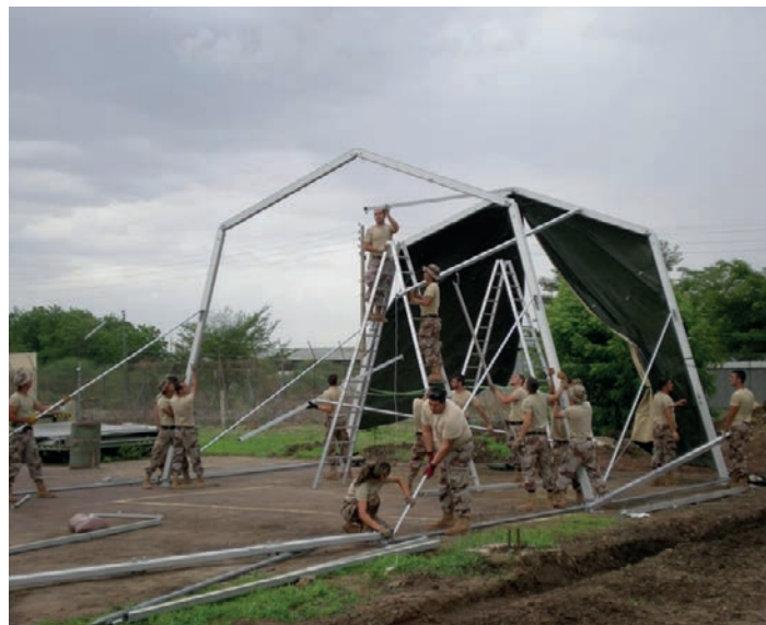
Montaje campamento Chad
