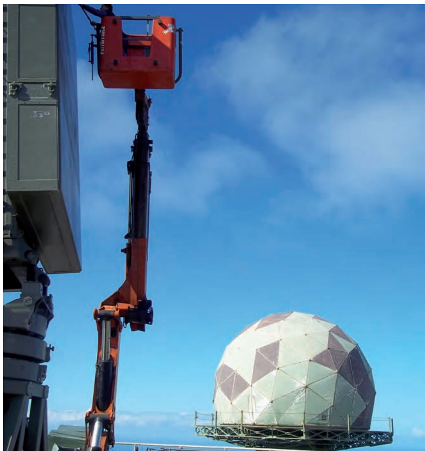
Trabajos de reparación en antena radar del EVA 22.
