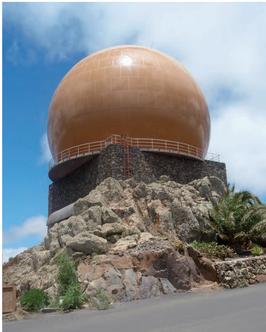
Radomo antes de su destrucción.
