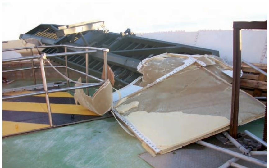
Antena de radar secundario del RAT-31 desprendida de su emplazamiento.
