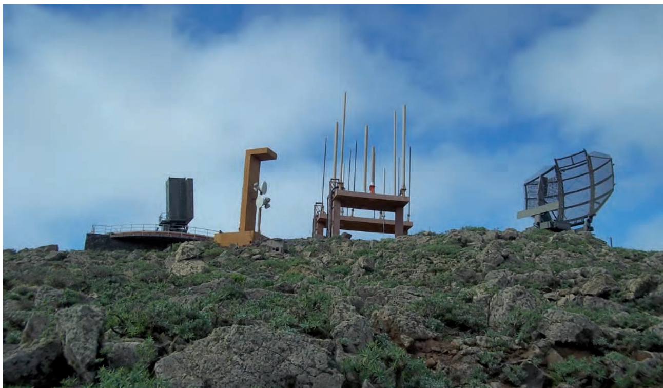
A la izda. RAT-31 sin radomo y con desperfectos en la antena y a la dcha. AN/TPS desplegado.
