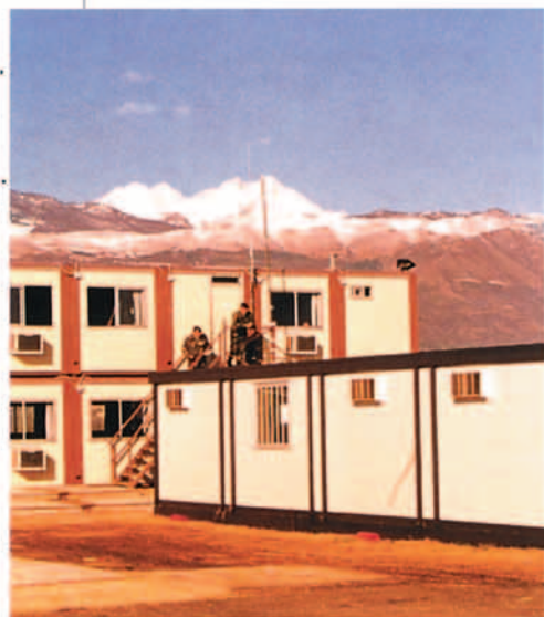
Vista parcial de las instalaciones desplegadas y montadas por la EADA.
