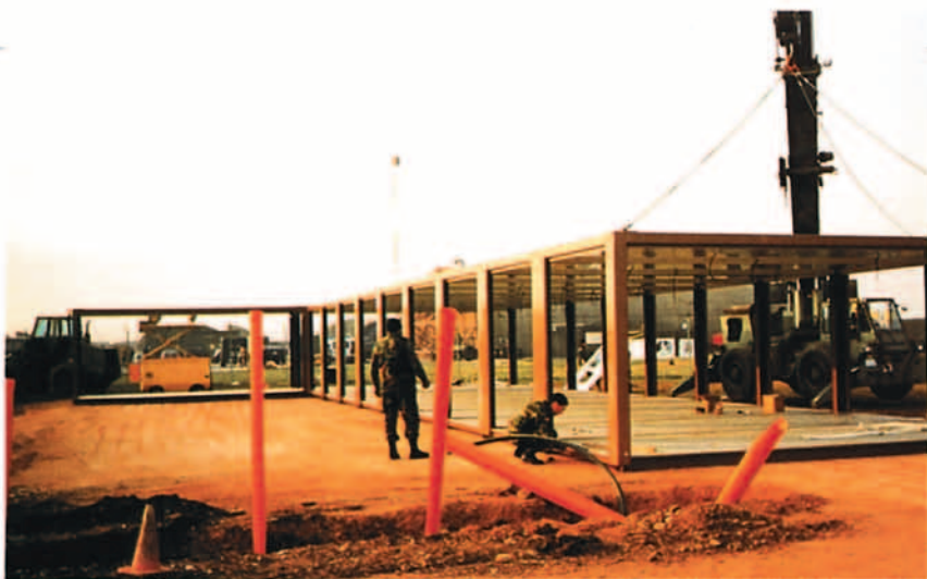
La falta de medios se suplía con el esfuerzo personal ante la necesidad de preparar el terreno.
