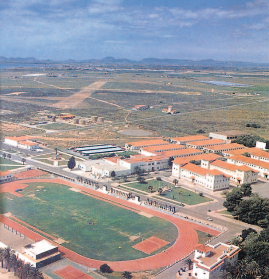
Vista actual de la Academia General del Aire
