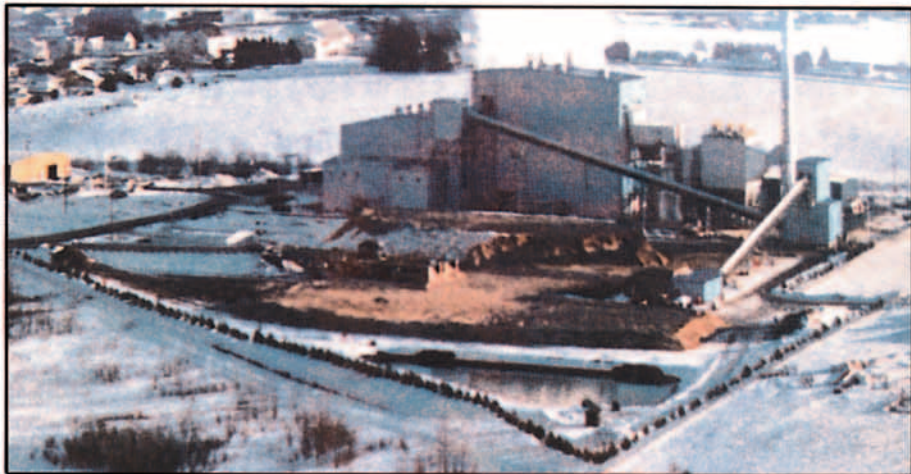
Central Térmica de Cogeneración Fort Fairfield Maine (E.E.U.U.).
