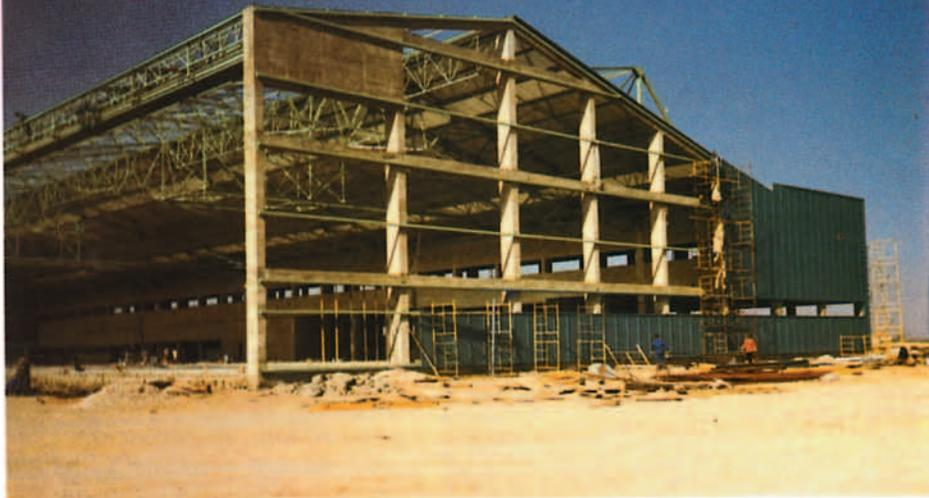
Estructura lateral de un hangar en construcción para la Maestranza de Albacete, se destinará a mantenimiento del avión CL-215.
