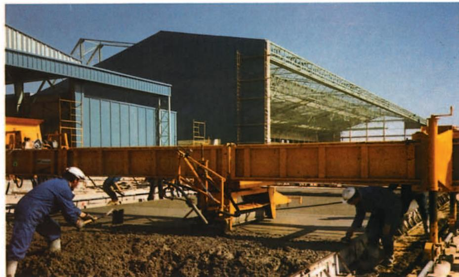
Operación de hormigonado de losas en la pavimentación de un estacionamiento.
