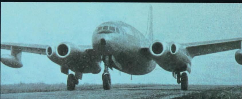
*El Sud-Ouest SO.30P-02 Atar nació como banco volante de ensayos para los motores SNECMA Atar.*
