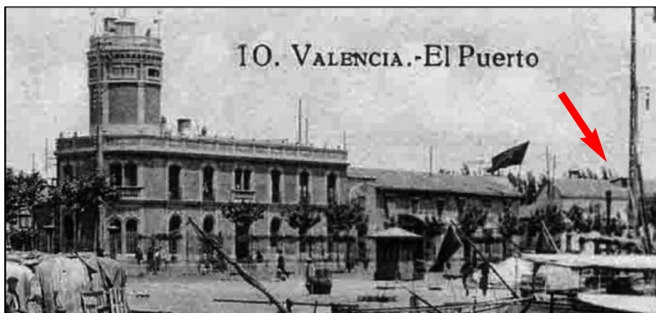
1915, Casa de Socorro y edificio de la Comandancia de Marina
