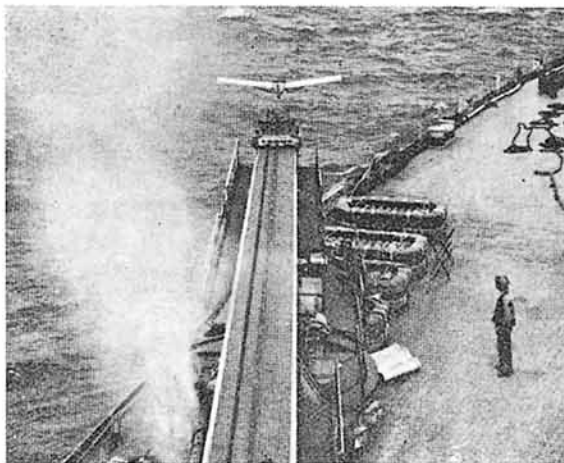
Blanco aéreo catapultable desde buques de la Armada norteamericana, y que se utiliza para la práctica artillera.
