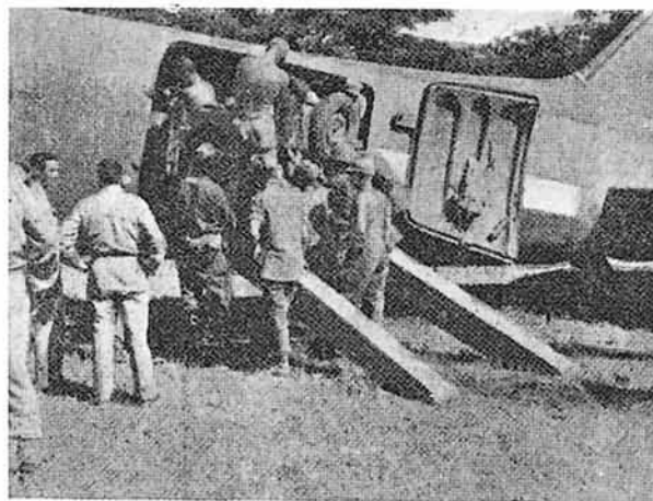
Embarque de una gran niveladora previamente despiezada en taller.
