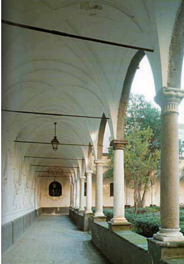
Figura 8.- Nápoles, complejo conventual di Santa Maria la Nueva, detalle del gran claustro
