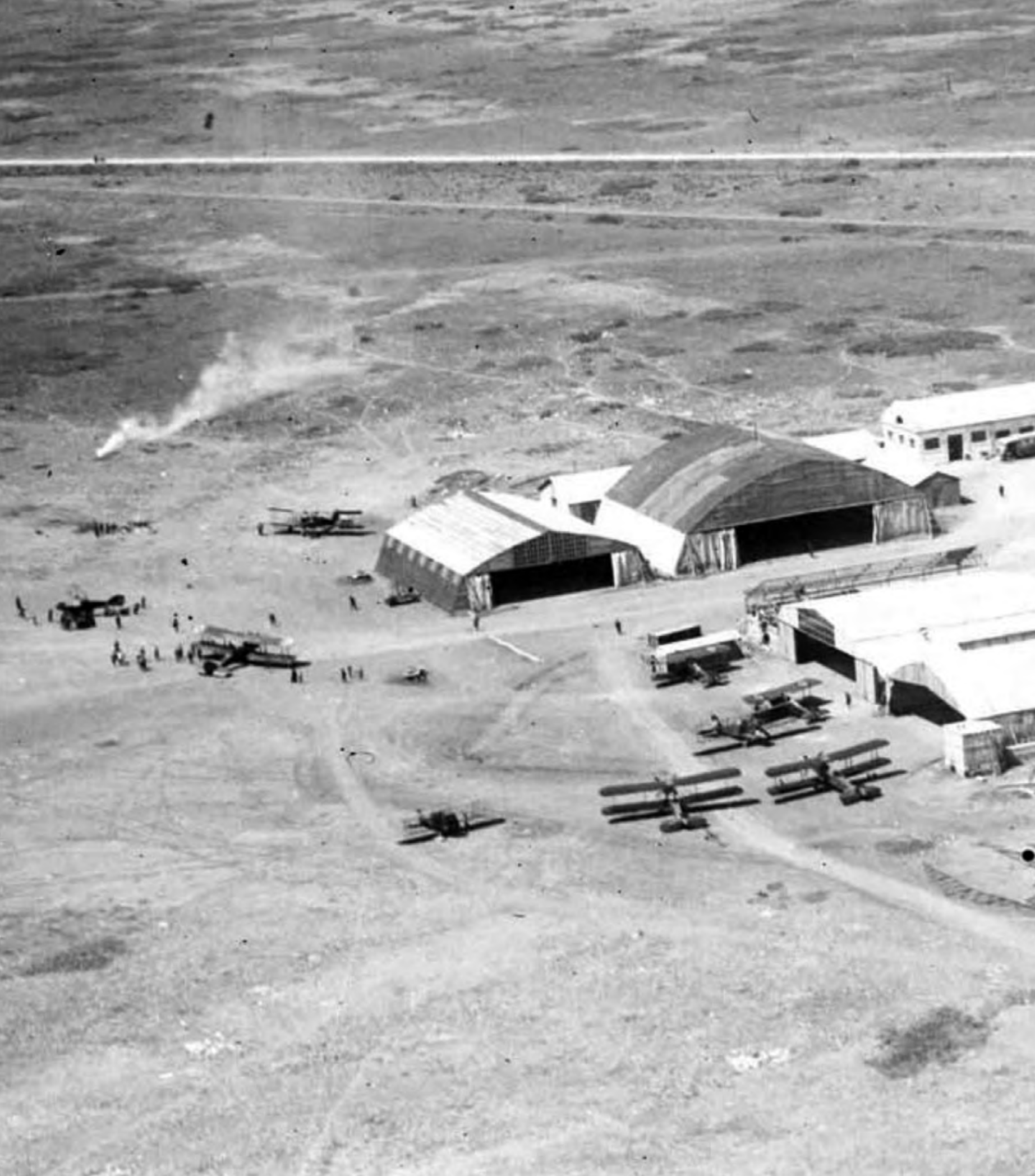
Aeródromo de Nador - Tauima (1921) – (SHYCEA). Todavía en construcción, se ve la estructura al aire de uno de los hangares. Los aparatos que se distinguen son DH4.
