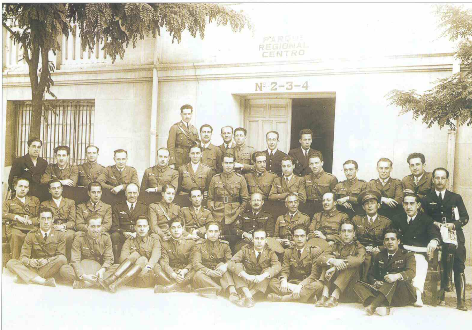
Entrada al Parque Regional Centro. Parte posterior al edificio.
