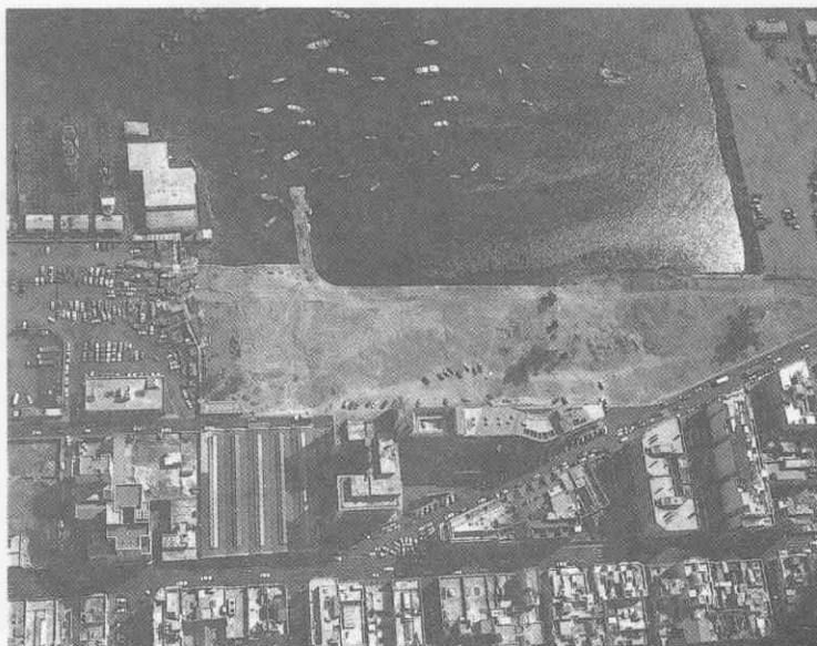
Base Aérea de Hidros de Puerto de la Luz, con sus instalaciones demolidas
