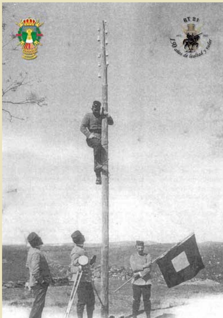
MONTAJE DE RADIOTELÉGRAFO Y HELIÓGRAFO, 1922
