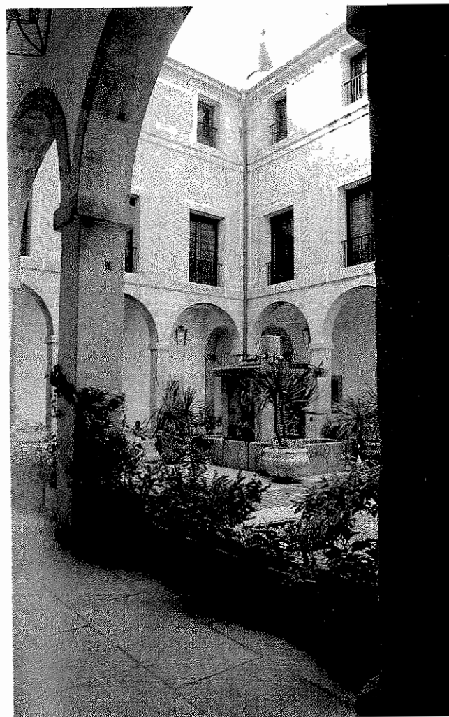
Vista del patio desde el vestíbulo de entrada.
