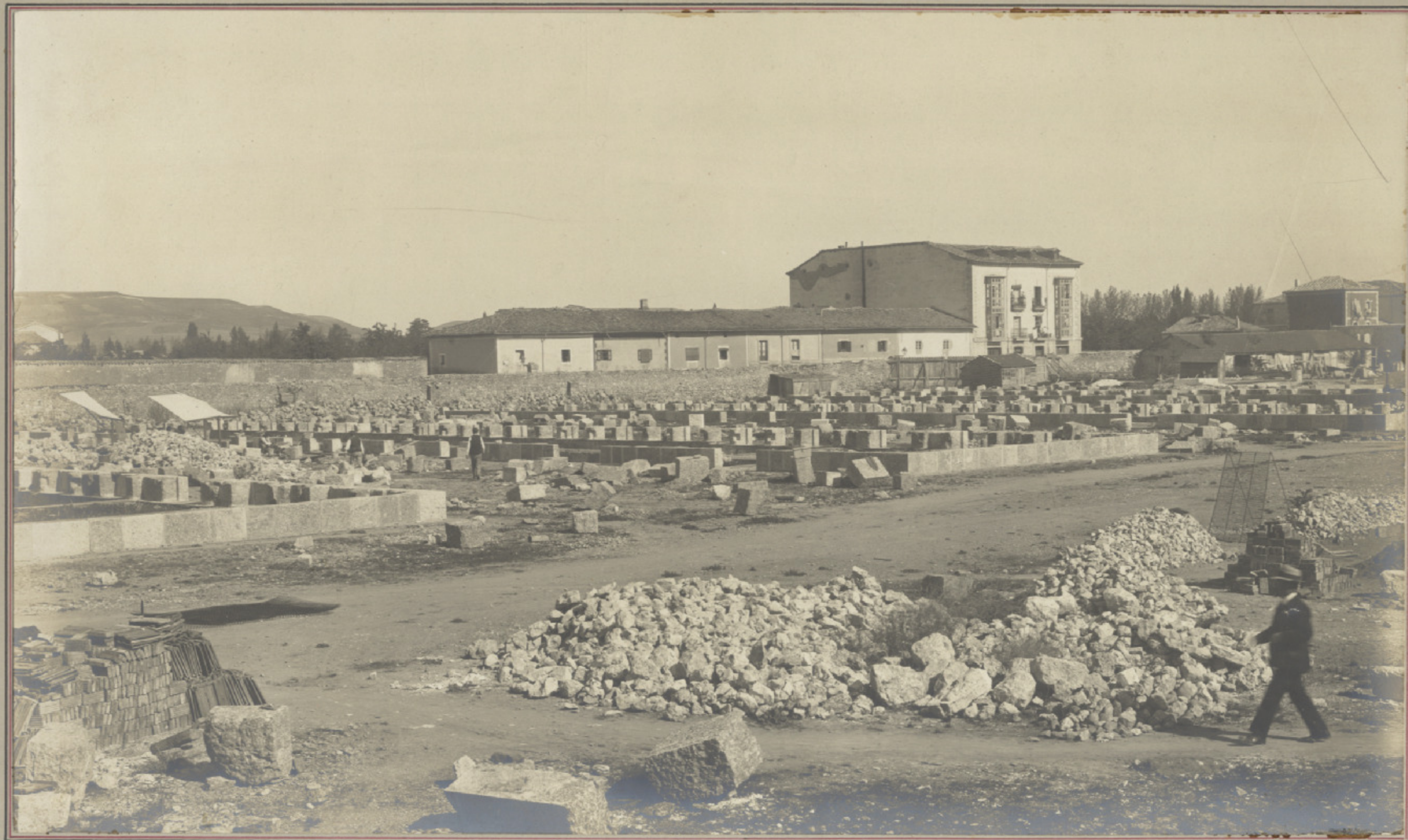
Estado de la obra en 11 de Octubre de 1909.
