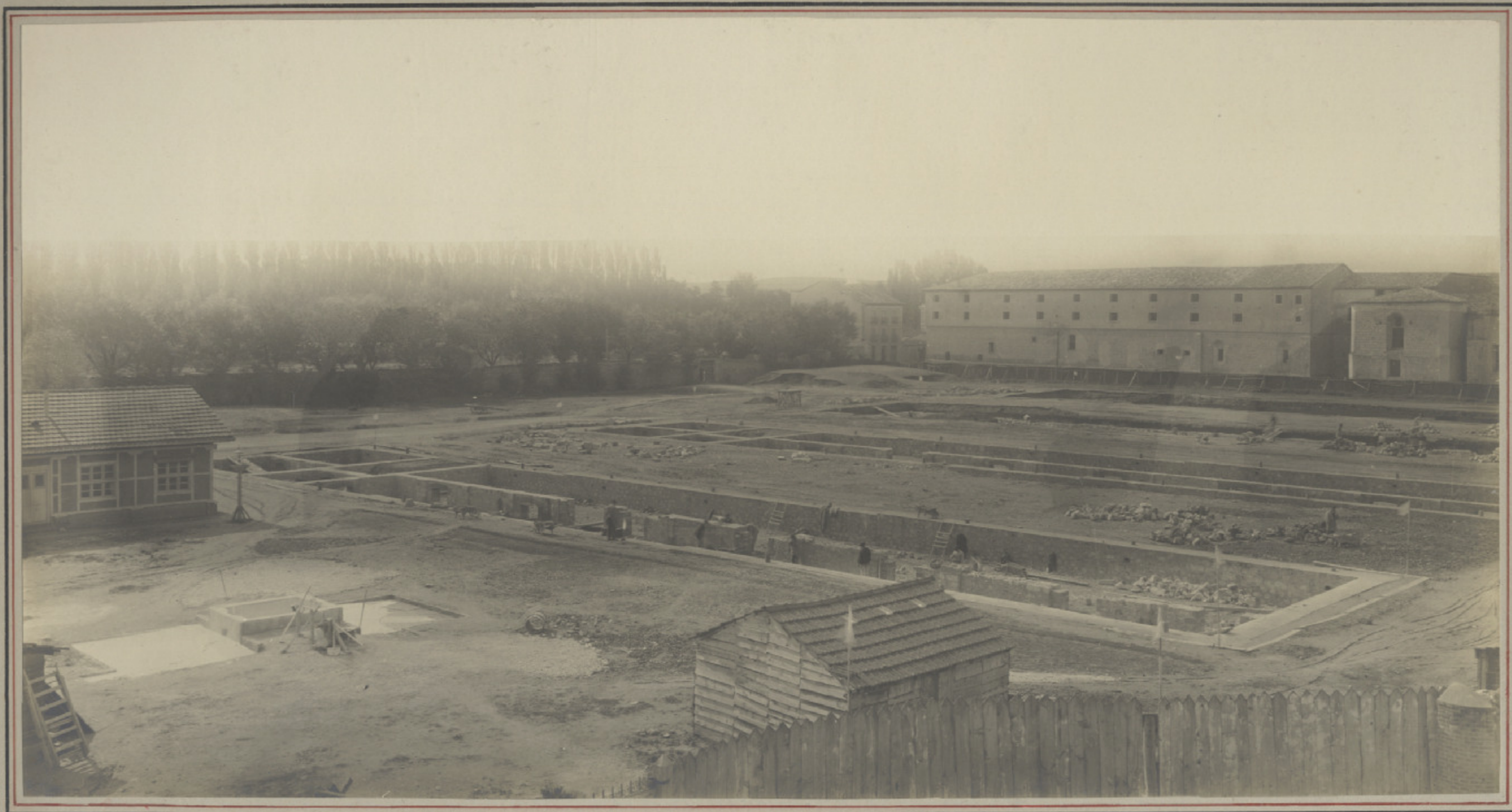
Estado de la obra en 16 Octubre 1907. Vista general.
