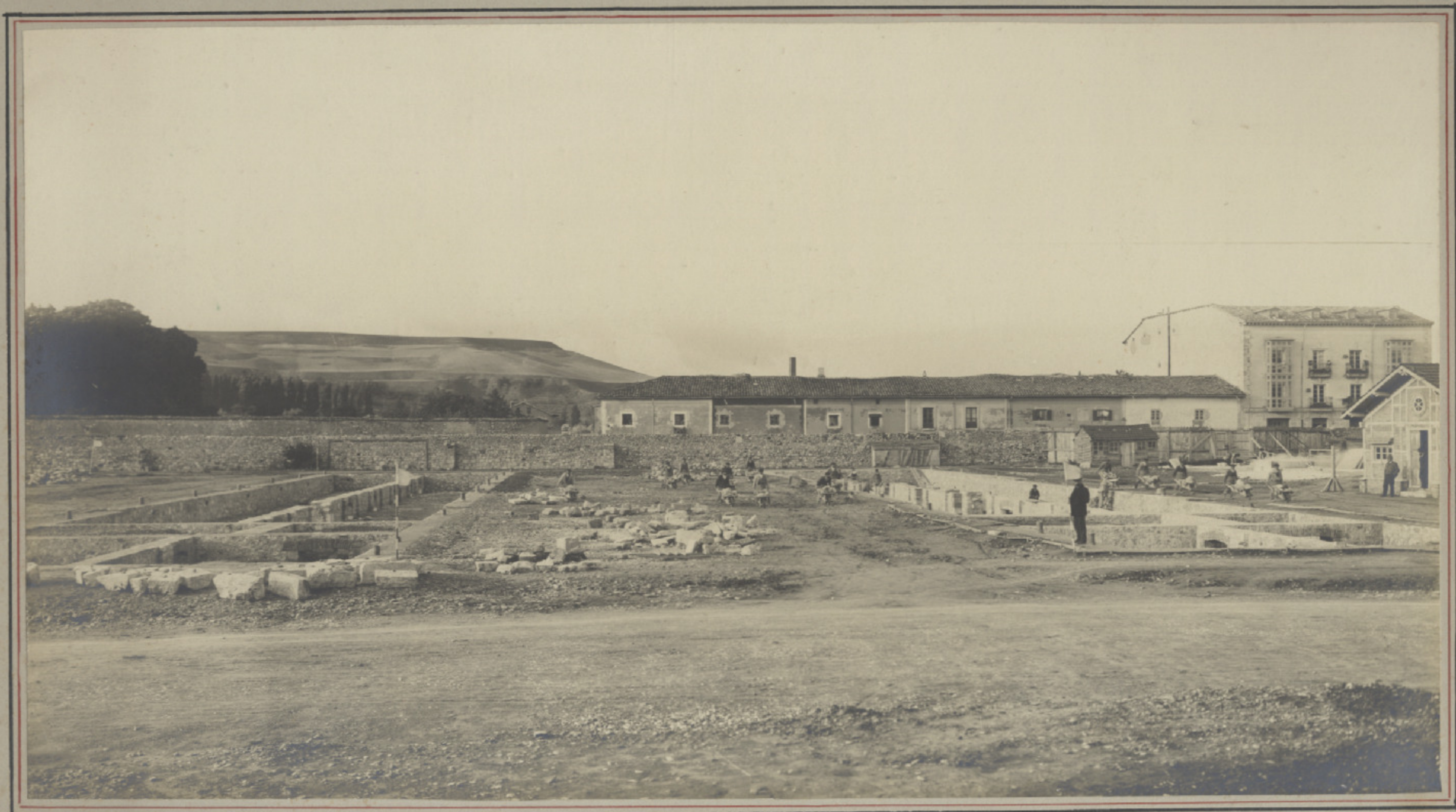
Estado de la obra en 16 Octubre 1907. 1º y 2º Pabellones
