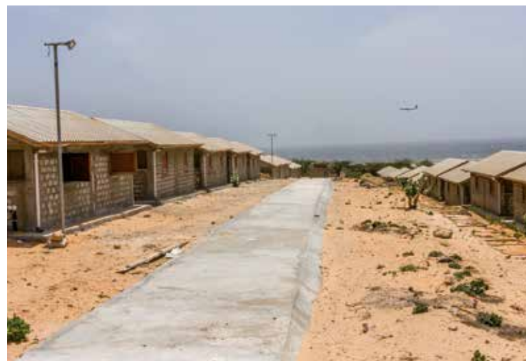
Vista general del Acuartelamiento JTC
