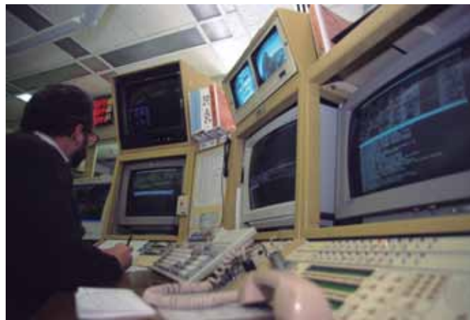
La estación de Robledo ha modernizado sus antenas y redes de comunicación a lo largo de estas cinco décadas.
