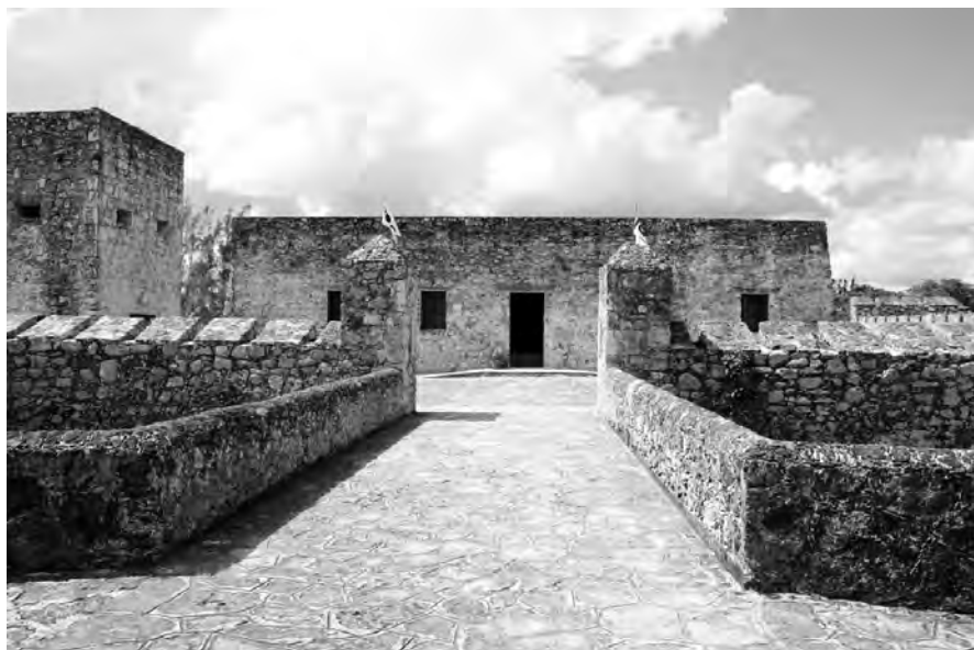
Baluarte de acceso al patio de armas del fuerte.
