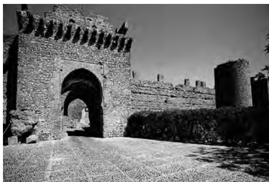
Puerta de acceso al alcázar en su estado actual.
