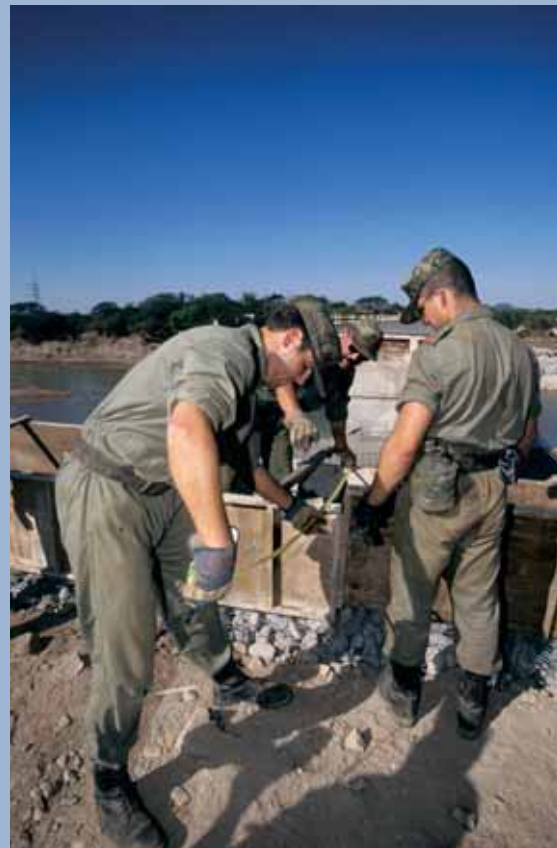
El tendido de un puente sobre el río Guasaule en Centroamérica, fue uno de los mayores retos del REI 11.
