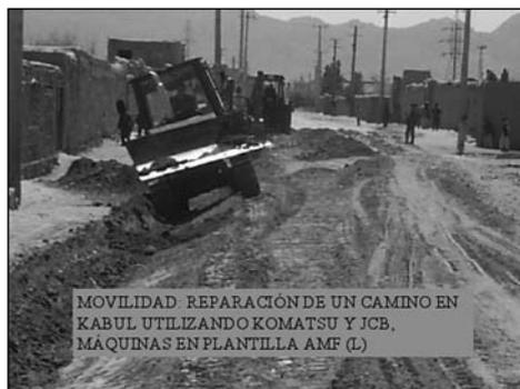
MOVILIDAD REPARACIÓN DE UN CAMINO EN KABUL UTILIZANDO KOMATSU Y JCB, MAQUINAS EN PLANTILLA AMF (L)
