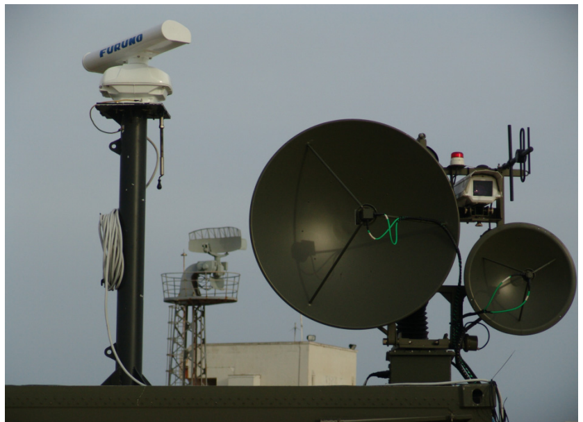
Fig. 2. Imagen del mástil de antenas de LIBRA.
