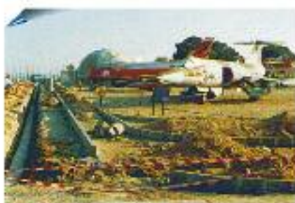
Obras de replanteamiento exterior
