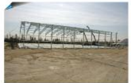
Hangar nº 6 en construcción
