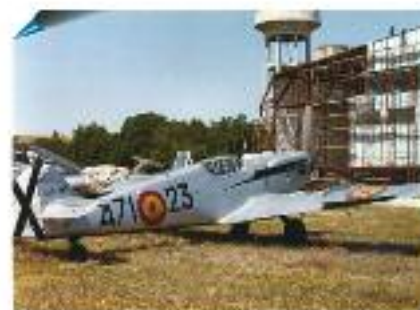
Obras de adecuación del hangar nº 1
