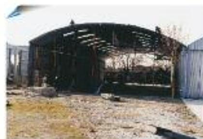
Ampliación del hangar 2 en construcción
