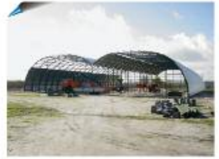
Hangar nº 5 en construcción
