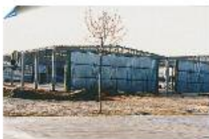
Hangar nº 3 en construcción
