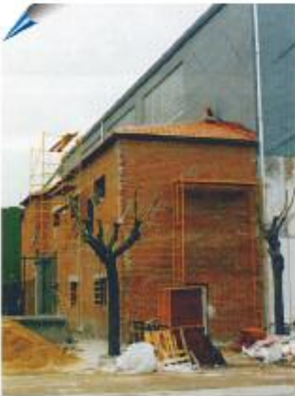
Adosado al hangar 1 en construcción
