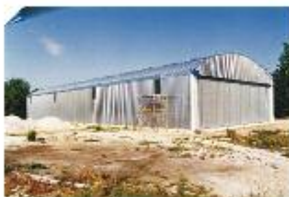
1ª fase del hangar nº 2
