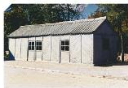
Caseta de S. Fernando antes de cubrir
