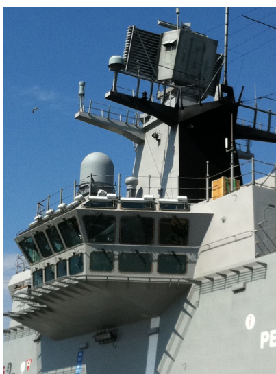
Fig. 3. Antena del subsistema ECM ya instalada en el buque LHD "Juan Carlos I".
