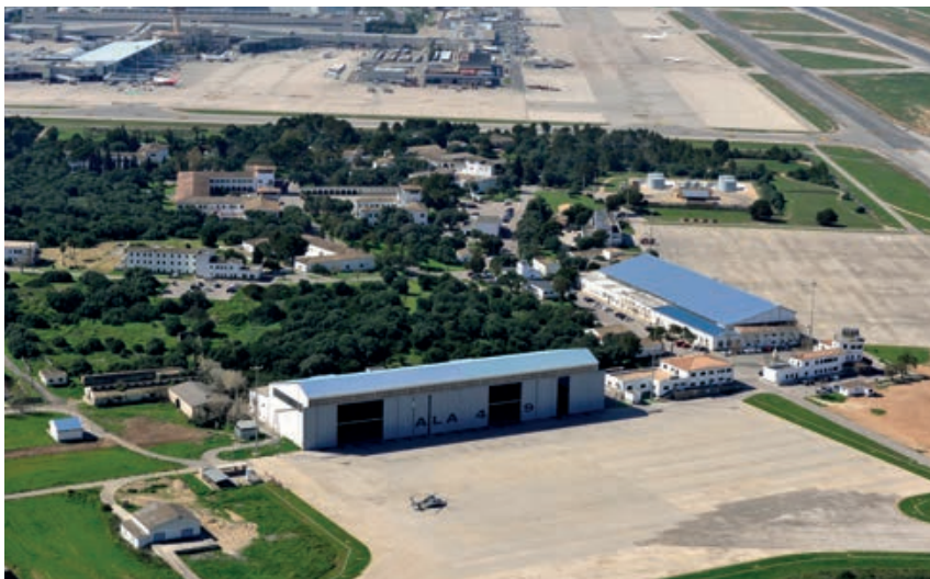
Vista de la base aérea en el año 2017
