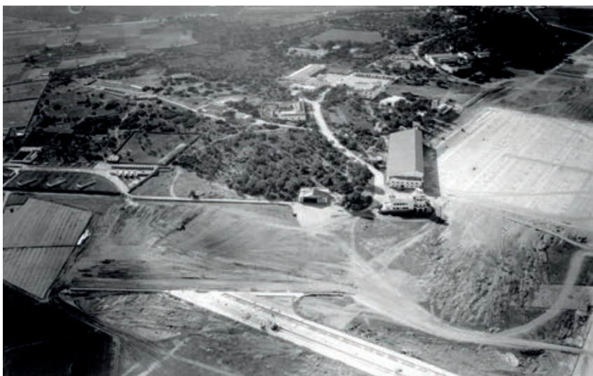
Vista de la base aérea en el año 1950
