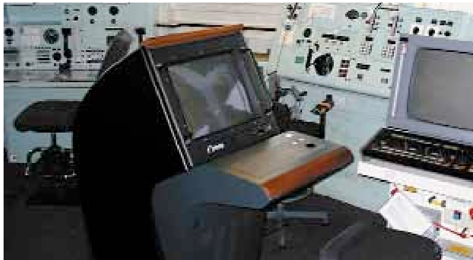
Instalación a bordo consola WECDIS.
