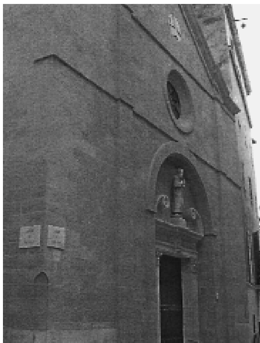
Fachada principal de la iglesia de San Juan de Malta.
