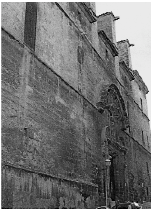
Fachada principal de la iglesia de Santa Cruz.
