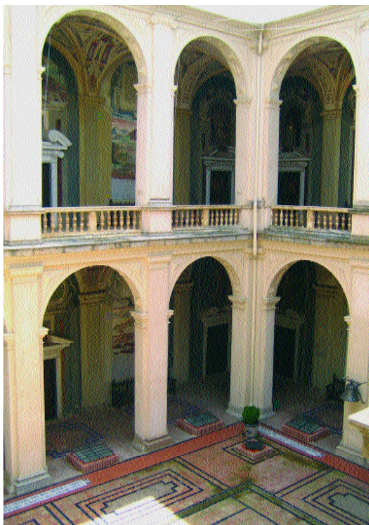
Esquina del patio y de las dos galerías. (Foto: M. González).
