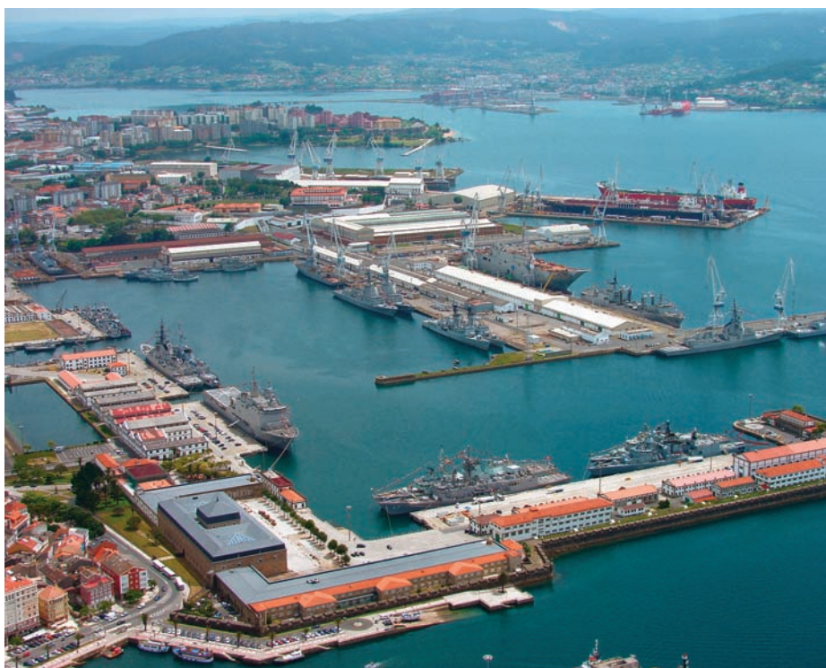
Vista aérea del Arsenal de Ferrol.
