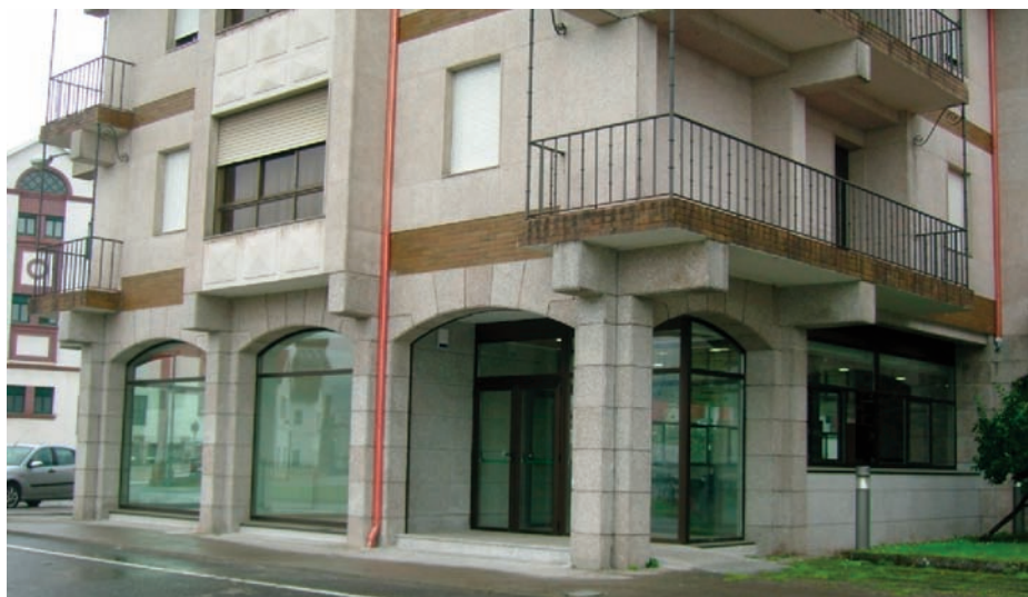
Biblioteca en el edificio Almirante Francisco Moreno .
