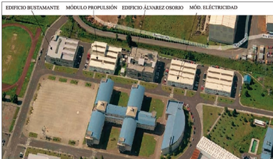
Vista aérea de la Escuela Antonio de Escaño.
