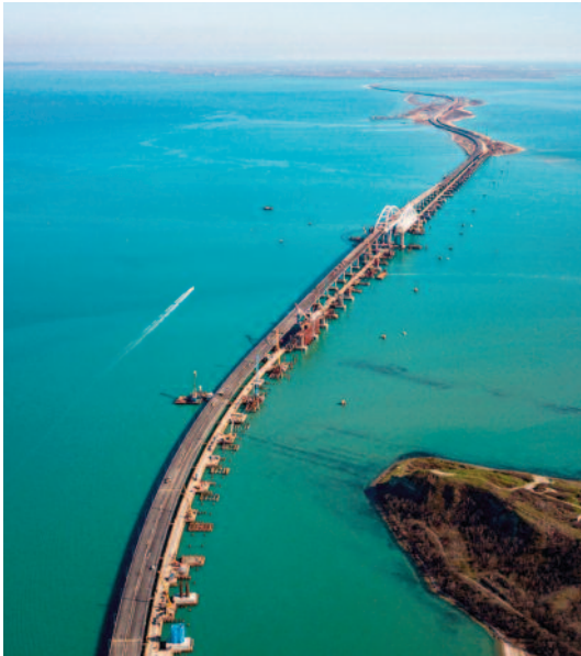
Vista general del puente de Crimea. (Fuente: internet).
