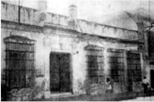
Una de las pocas fotografías de la Casa de Reyna antes de su derribo.
