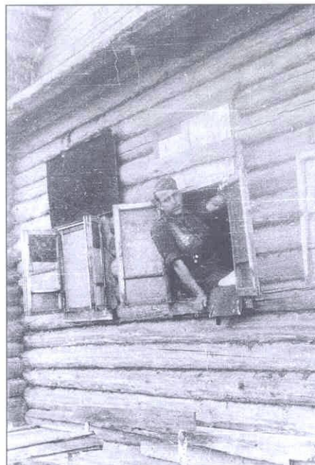
Exterior de un barracón en el hospital de campaña de Mestelewo.
