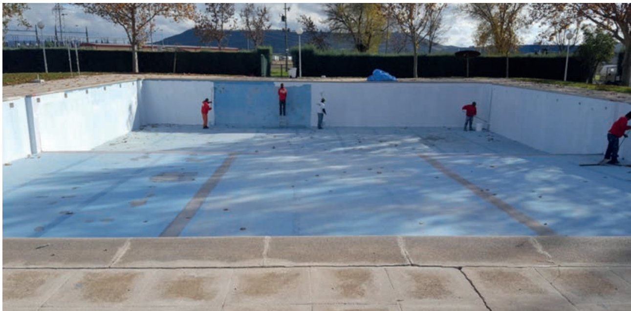
Obras en la piscina de la base aérea de Torrejón
