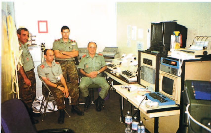
Interior del centro de comunicaciones
