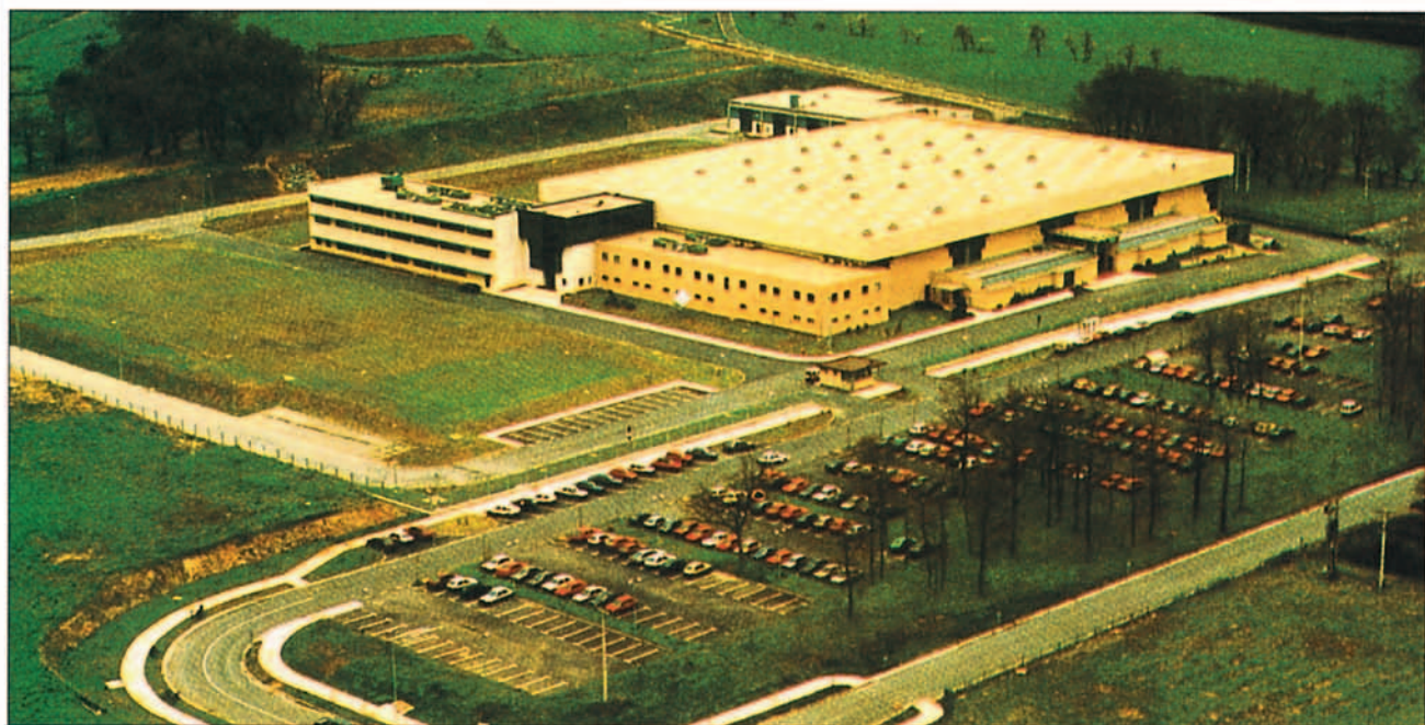
Instalaciones de ITP en Zamudio (Vizcaya).
