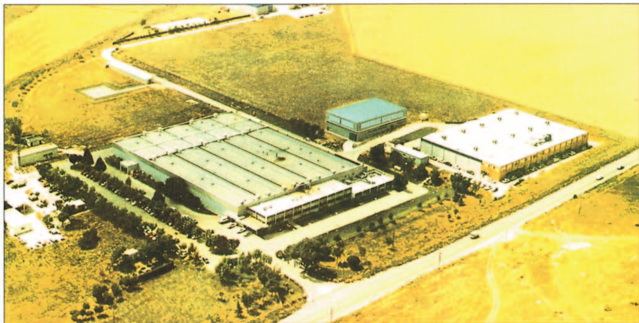
Instalaciones de ITP en Ajalvir, Torrejón de Ardoz (Madrid).
