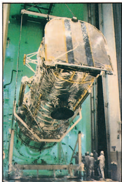
Figura 9. Montaje por Lockheed, del HST (Hubble Space Telescope) que será lanzado por una Space Shuttle antes de finalizar 1989.
