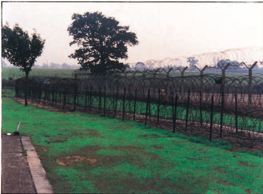
Seguridad perimetral. Valla exterior con concertina en su parte superior.
