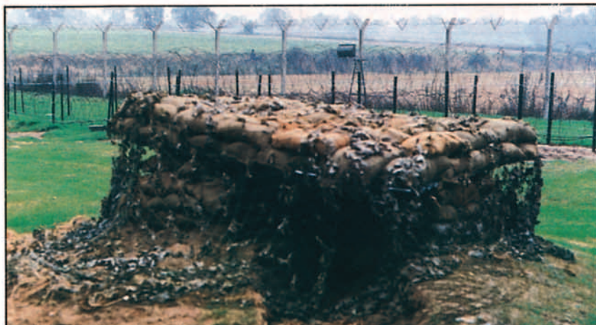
Seguridad interior. Puesto de observación construido con sacos terreros, láminas onduladas, contenedores rellenos de tierra y redes de camuflaje.
