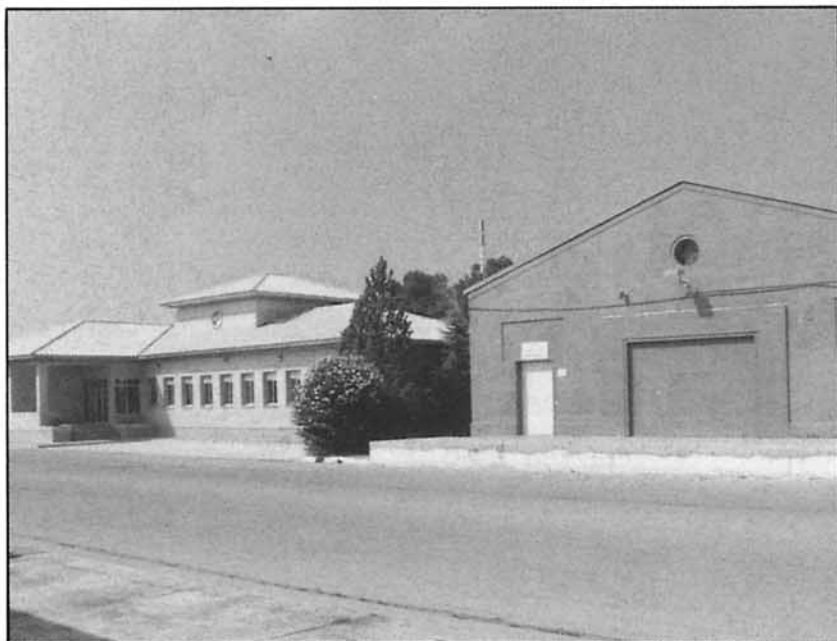
CIM. Edificio de Aulas y Simuladores. Edificio del Simulador de Vuelo.
