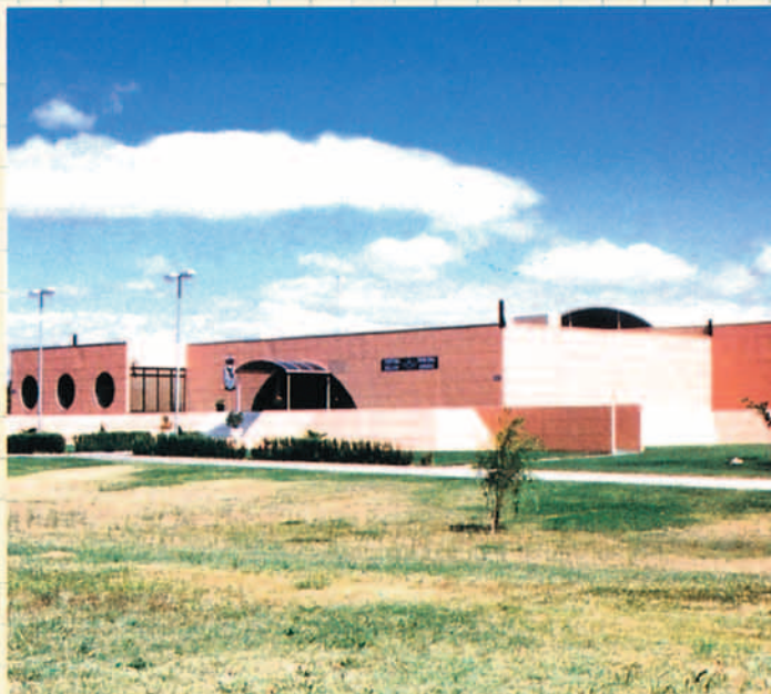
Vista general del edificio C.P.H.E.
