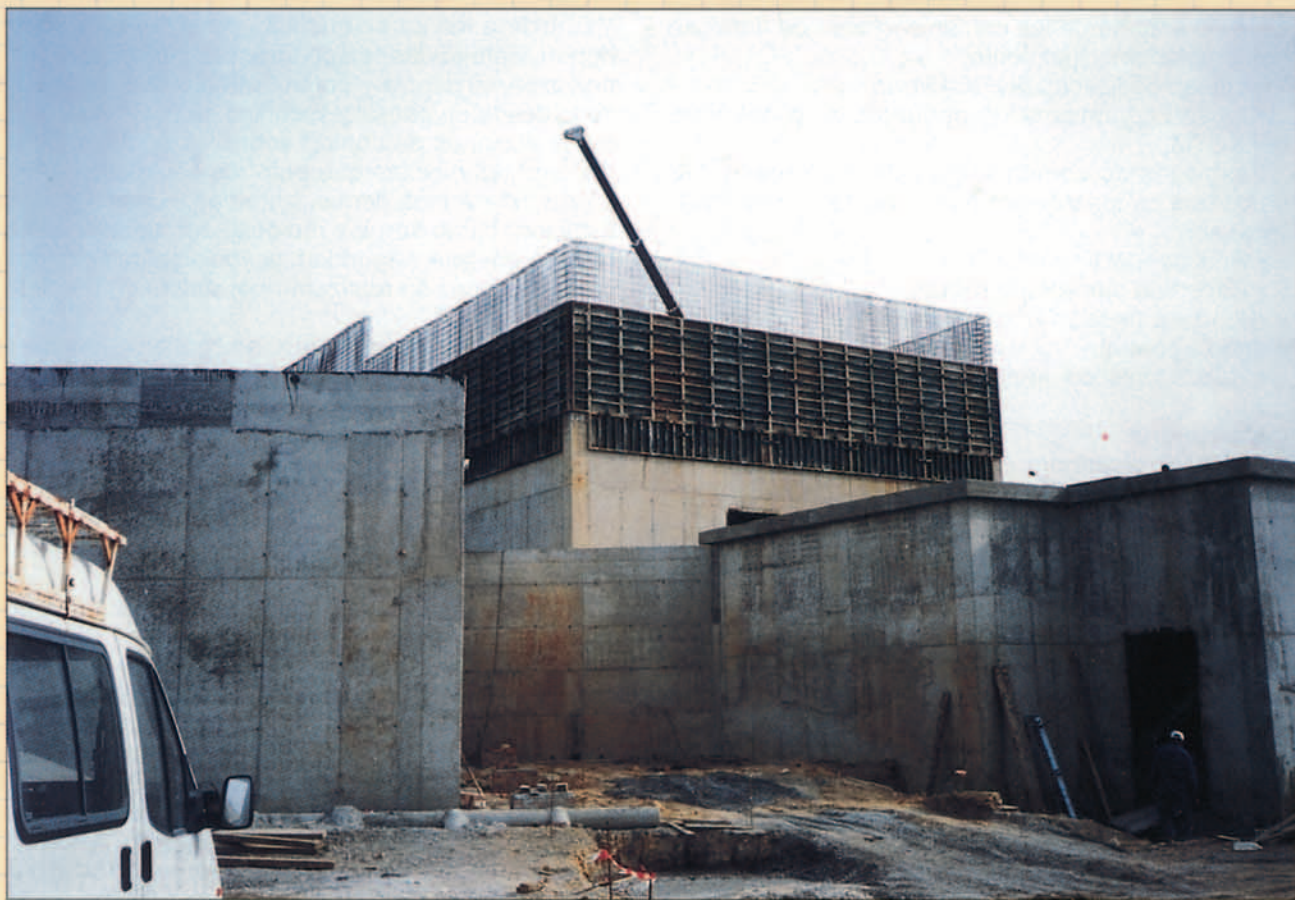
Centro de comunicaciones de un EVA en construcción.
