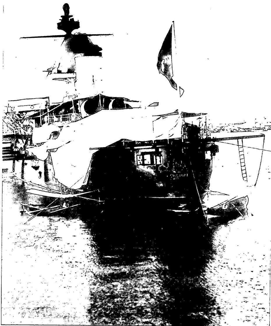
Detalle de la popa del crucero acorazado Cristóbal Colón . Se observan las baterías de babor: la inferior compuesta por 5 piezas Armstrong de 152 mm y la superior con 3 piezas de 120 mm y tiro rápido. Fotografía de Enrique Rolandi Pera, marzo de 1898. (Archivo familiar.)
