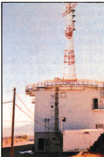
Estaciones principal y remota del subsistema de instrumentación y seguimiento (TIS). Esta última alimentada por placas de energía solar.
