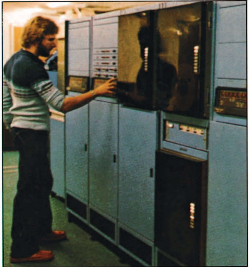
Subsistema de control y computación (CCS) en donde se realiza el procesamiento, registro y transmisión de datos al DDS. El CCS puede ser transportado en vehículos remolcados dando, de esta manera, una gran flexibilidad al sistema.
